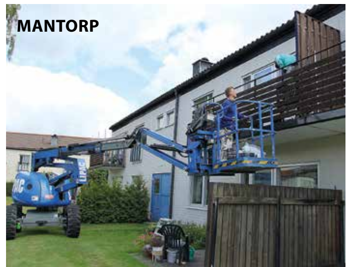
Målningsarbetena pågår för fullt på Ubbarp. Här är det balkongräcken som får ny färg.
