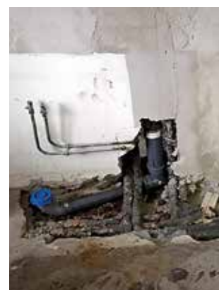
Gamla rör måste huggas fram och bytas ut.
