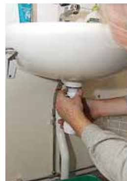
Sätt tillbaka vattenlåset. Var noga med att tätning följer med och att det sitter rakt.
