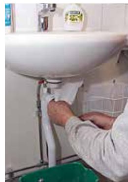
Torka ur röret med papper. Är det mycket hår, släng i soporna inte i toan.
