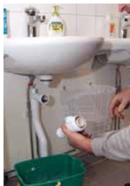
Lossa ringarna mot handfat och avloppsrör. Ta loss vattenlåset. Ta bort skräp, diska ur.
