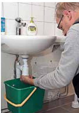
Stopp i handfatet. Sätt en hink under och skruva av bottendelen i vattenlåset, vattnet rinner ut.
