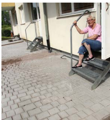
I Väderstad har en ny metod för gjutning av uteplatser testats med gott resultat.
